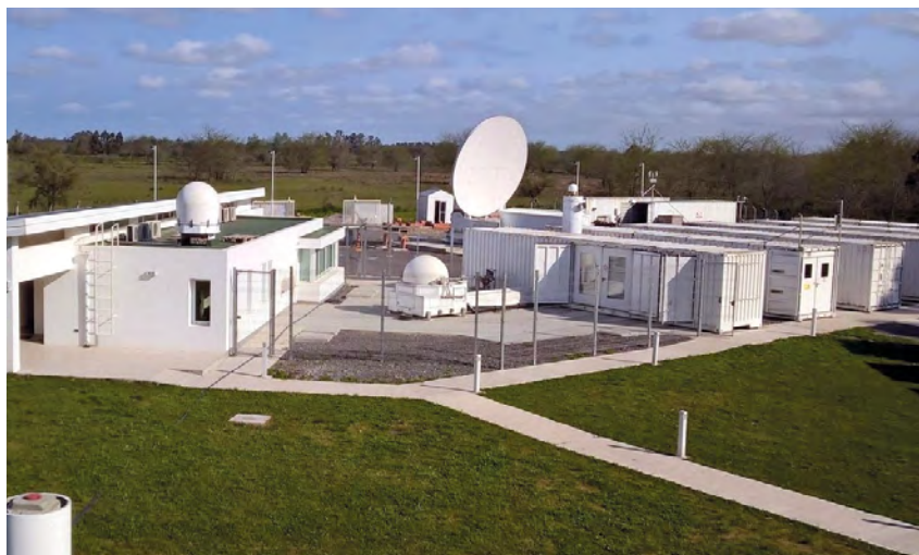
FIGURA 4 – Foto aérea del Observatorio Geodésico Argentino-Alemán (AGGO). En la misma se aprecian las instalaciones, los receptores GNSS, y las antenas SLR y VLBI ( https://www.ago-conicet.gob.ar/observ.php ).
